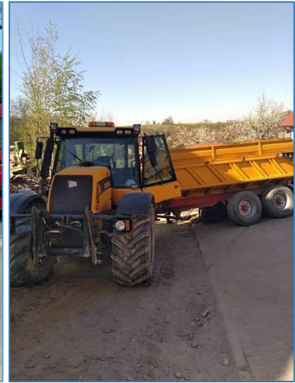
Uszkodzony przyłącz gazu 23.04.2020
