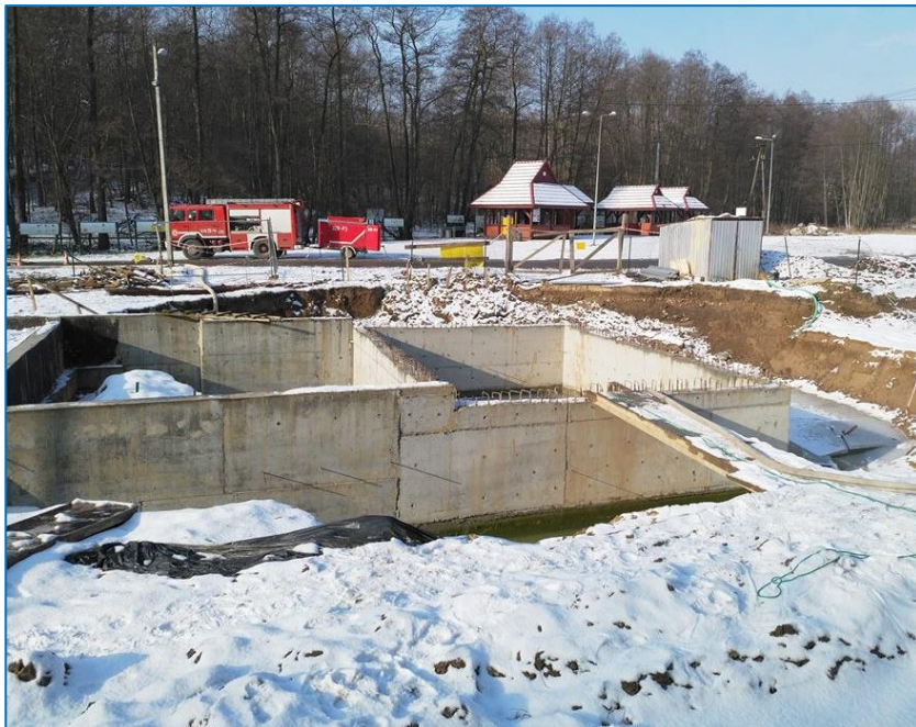
17.02.2018 r. Pompowanie zalanych fundamentów powstającego budynku Klubu Sportowego KS Topór w Aleksandrowicach
