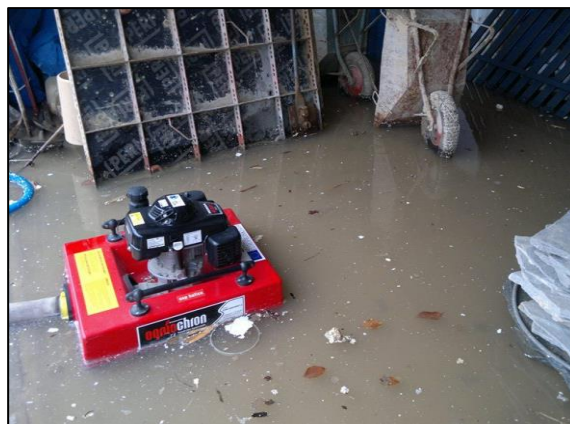
Wypompowanie wody z zalanego budynku – Burów – 11.01.2015 r.
